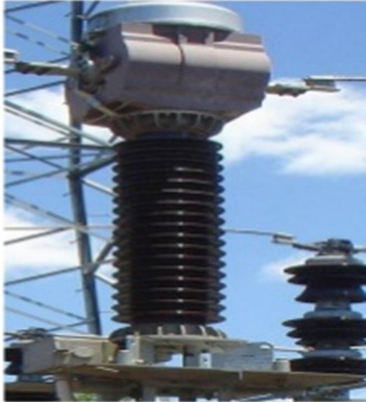
Transformador de Corriente 69KV
